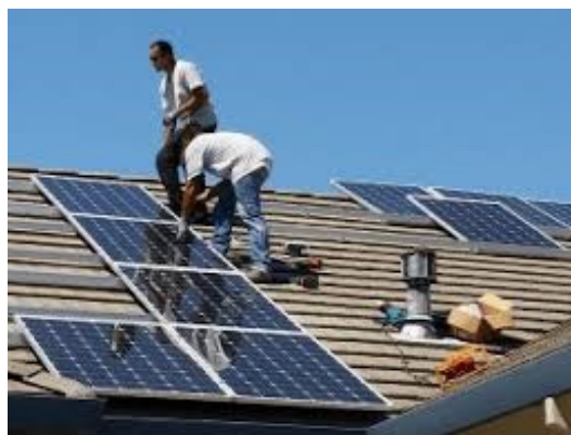
Instalação Solar em Telhados
