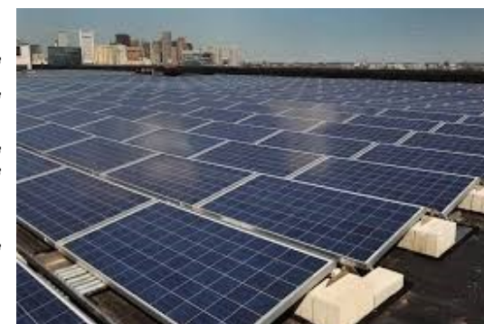
Instalação de Usinas Solares no solo
